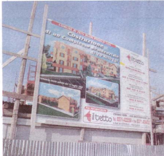
Uno dei cantieri avviati dalla cooperativa Il Tetto a Zelo Buon Persico
