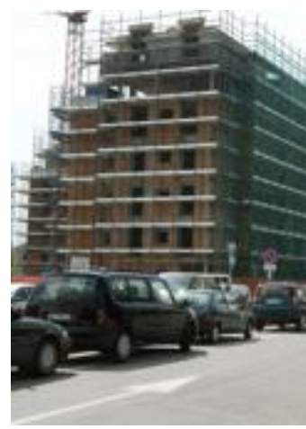
Un gigantesco cantiere all'Albarola
